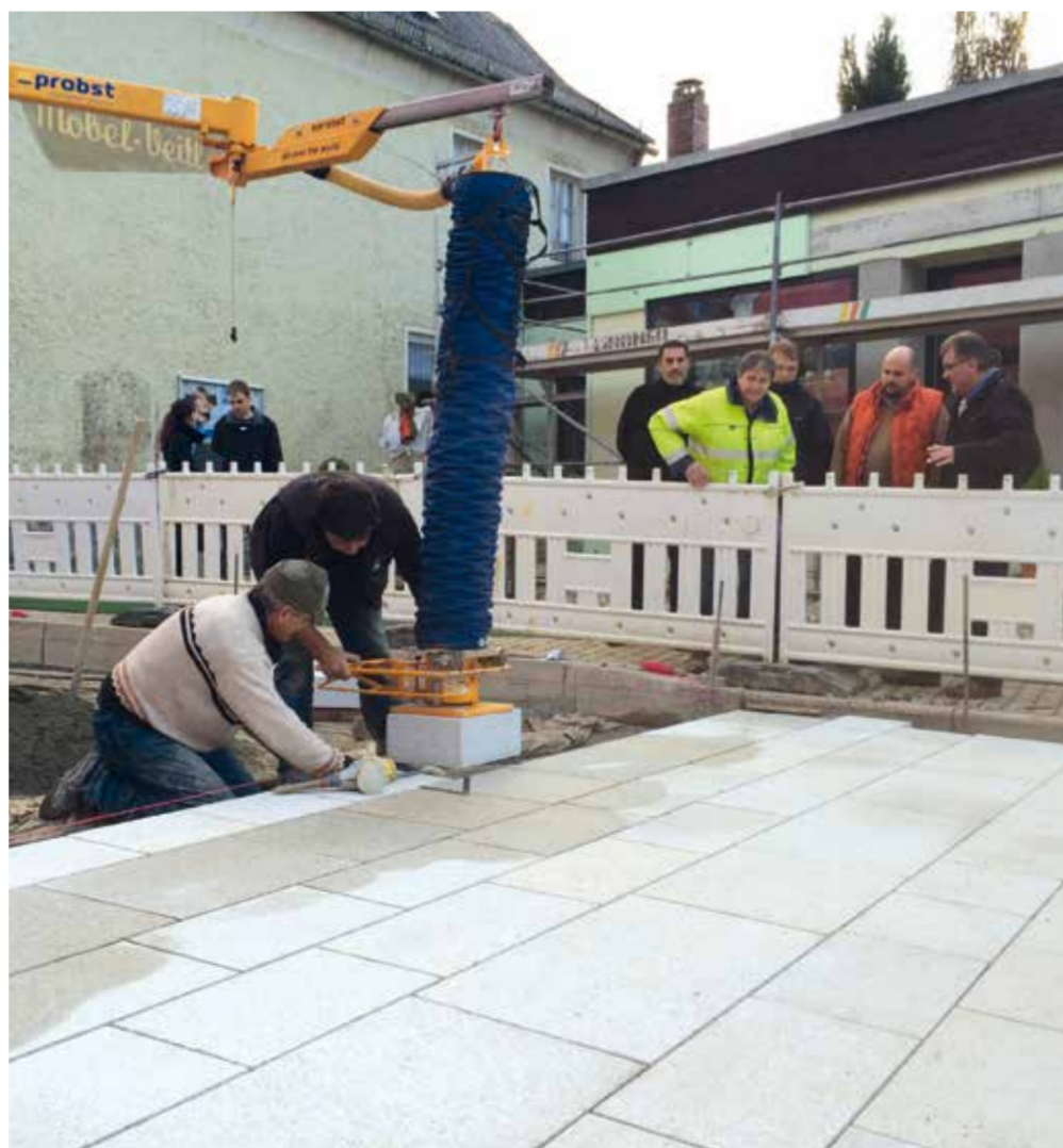
Ansaugen, ausprobieren, kleben und passgenau einsetzen. Mit dem Vakuum-Hebegerät war das Verlegen der großen Steinplatten ein Kinderspiel. Rund 30 Quadratmeter wurden täglich geschafft.
