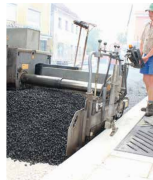
Schweißtreibend: Asphaltierungsarbeiten im Sommer bei 30 Grad.
