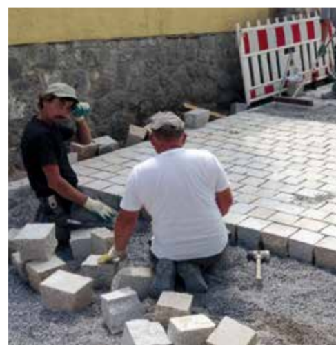
Bauarbeiter verlegten die Granitplatten auf eine Bettung aus Splitt.
