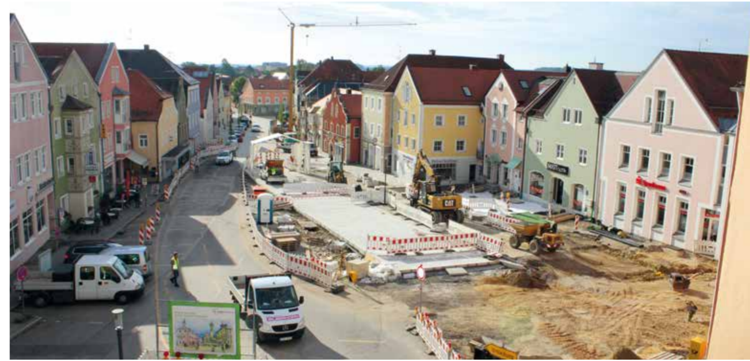
Eine Großbaustelle: Fahrbahnbelag stückweise abtragen, Unterbau mit Frostschutzschichten einbringen, wasserdurchlässige Asphalttschicht einbauen und Granitmaterial verlegen. So arbeiteten sich die Bauarbeiter Stück für Stück vorwärts.
